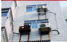
空调机歪斜/老化
