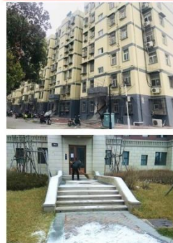
入口有台阶且无宽度足够上轮椅的坡道(1)
