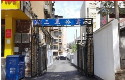
小区出入口未明显区分人行和车行入口(1)
