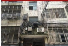
空调机歪斜/老化
